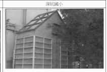
水資源利用 屋頂雨水節流再利用,儲存在40公噸水塔及雨水屋, 供應人工溪流、生態池。廁所廢水未再回收。
