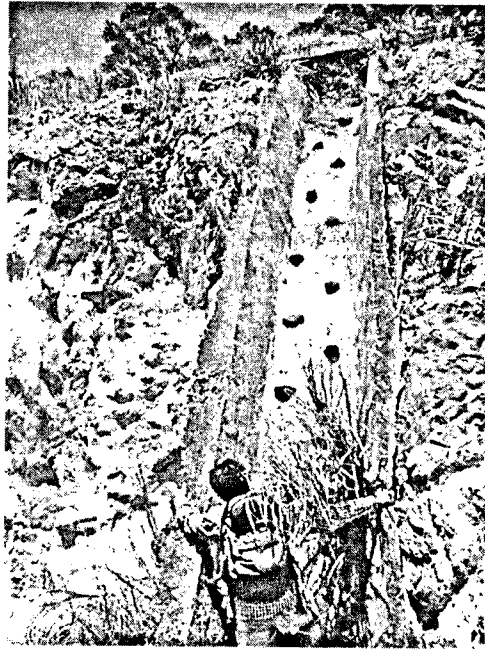
圖一：坡面上的排水溝
