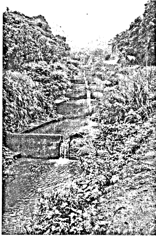
圖四：水磨坑溪的跌水工
