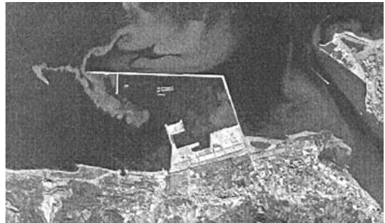
圖2 台北港防坡堤、碼頭及外廓工程衛星影像 資料來源：行政院海洋事務推動委員會（2006）。
