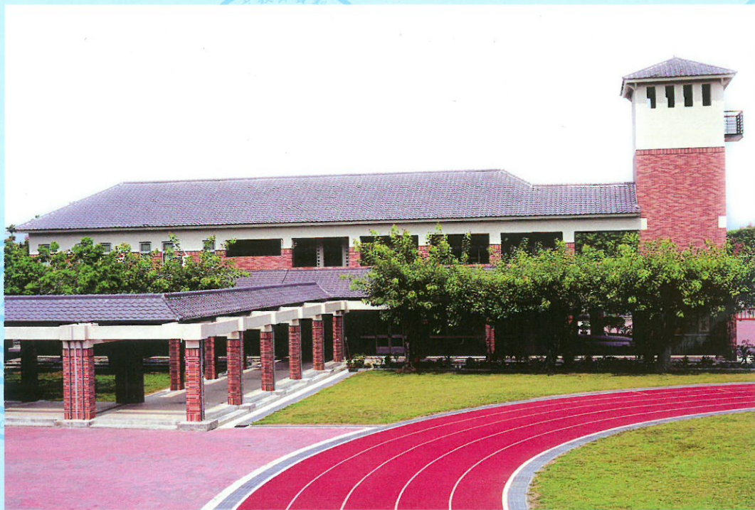
▲南投縣草屯鎮土城國小九二一震災後重建校景（原刊載「為下一代蓋所好學校—突破與創新—新校園運動專輯」，百巨國際文化事業股份有限公司拍攝提供。）
