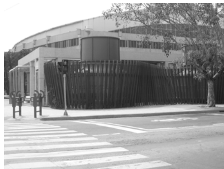
用木製柵欄美化水塔
