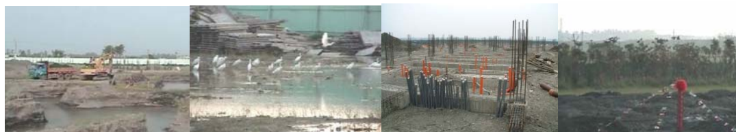
圖 20 施工在安全圍籬內 圖 23 管線施工時預先埋設 圖 22 原基地豐富生態 圖 24 表土暫行搬移堆置
