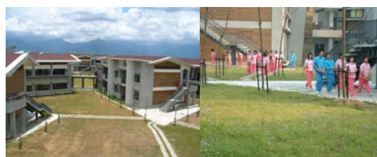
- 56 - 圖30 棟距間鋪設石板小徑做為通道
