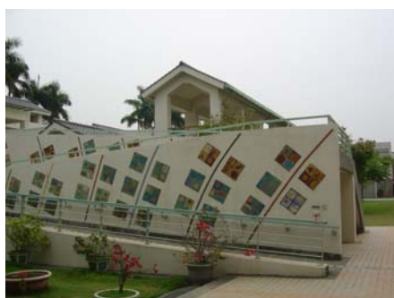
圖九、營盤國小之無障礙坡道 (作者，2007)
