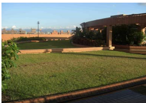
三重高中 屋頂多種生物植栽，增加綠化量及美觀，具有隔熱效果，減少頂層室內的能源消耗，惟經費不足，僅局部施作。
