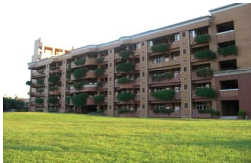
三重高中 建物立面種植紫藤等花木，增加綠化量，地坪為草坪，保水性強
