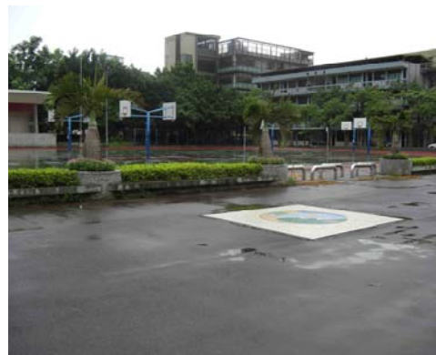
泰山高中 校園運動場廣設柏油地面，造成保水性不足，雨天地面積水，晴天太陽輻射熱地表溫度上升導致熱島效應，大量使用冷氣造成溫室效應
