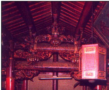
新港奉天宮後殿棟架，可見瓜筒成圓球形，瓜角分成三爪，成扁平狀似鴨蹄形
