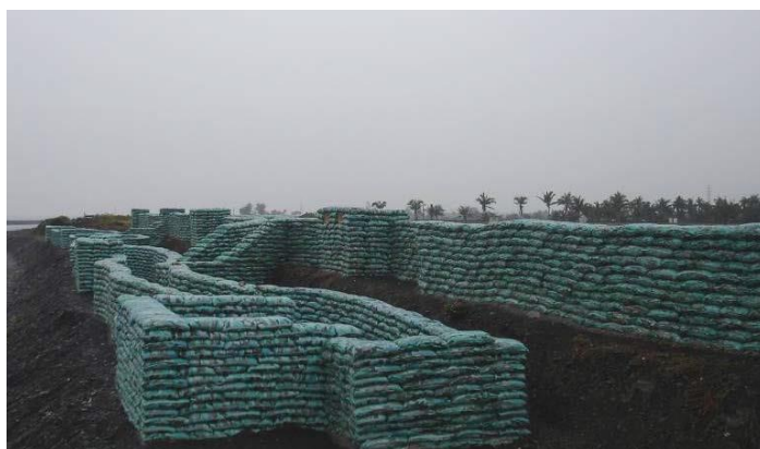
圖18：運用沙袋堆疊方式構築之戰壕、掩體。
