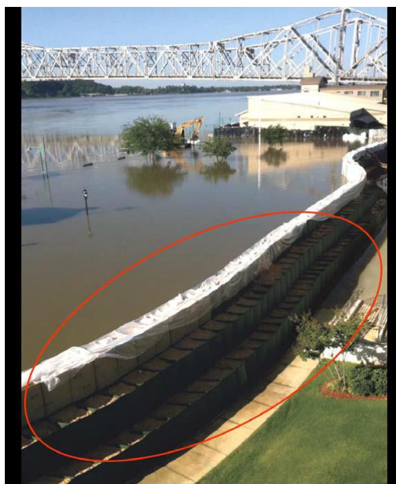
圖 7：可作為緊急防汛及控制侵蝕等使用。
