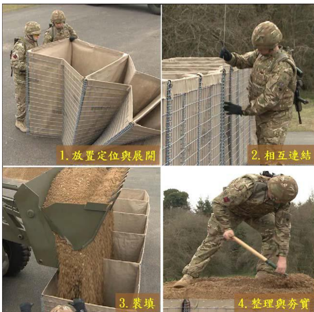
圖3：HESCO bastion 構築作業程序
