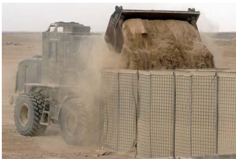
圖10：運用機械協助裝填，有效縮短工事構築時間
