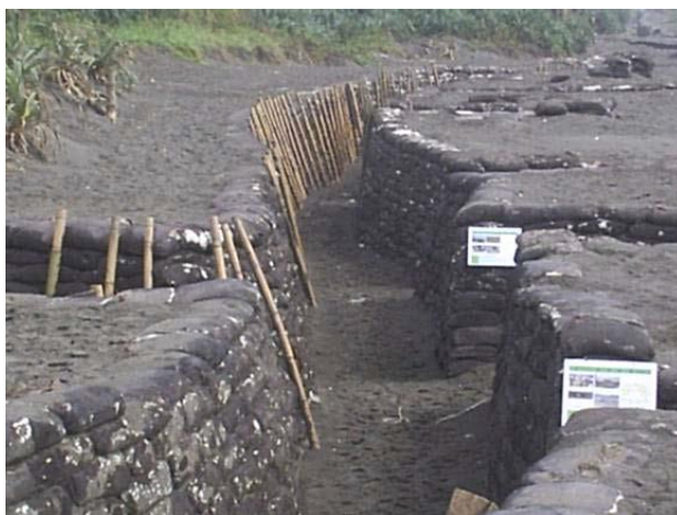
圖17：灘岸地區構築掘開式之戰壕、掩體。
