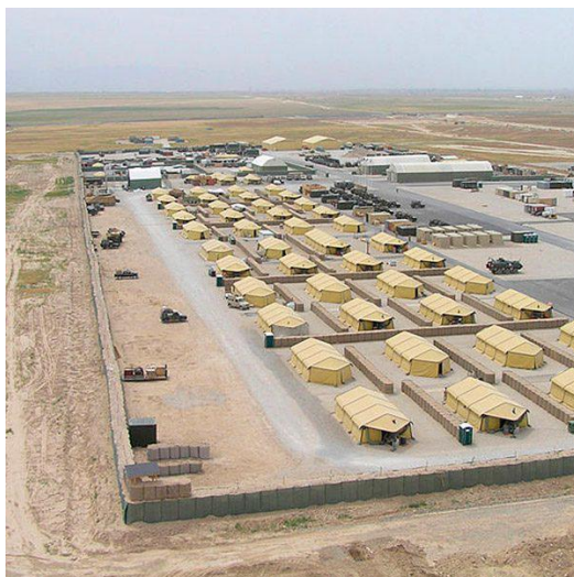
圖8：德國位於阿富汗馬扎里-沙里夫 (Mazer-e-sharif) 的基地，利用HESCObastion 構築防護圍牆。
