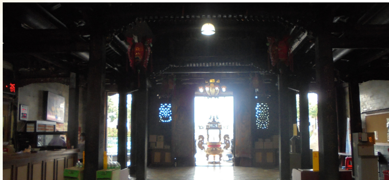
白熾燈下方、四根石柱的區域內即是福佑宮的戲亭。
