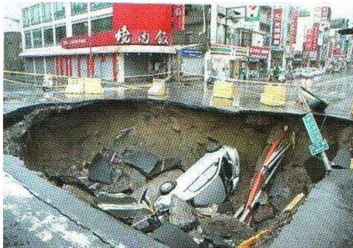
圖二：台南市永康市道路受損淘空，車輛掉落坑洞
