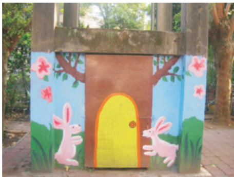
美化改造後的舊水塔局部放大
