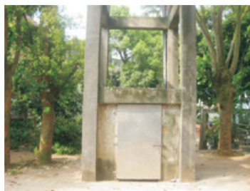
移除水管管路之後
