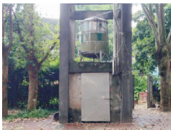
年久失修而廢棄的舊水塔
