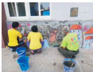
用水泥補縫隙 並洗淨磁磚表面
