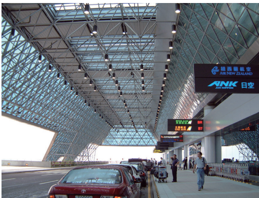
圖6-47 桃園機場第二航廈的外廊屋頂設計以線立體構成
