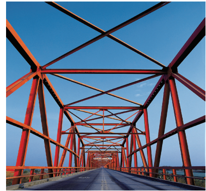
鋼架橋樑的結構
