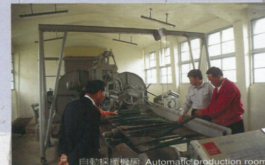
自動採織機房 Automatic production room
