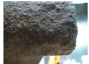
土垢、砲管鐵鏽移除後
