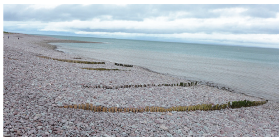
▲圖1、波洛克海灣上的木製防坡堤
