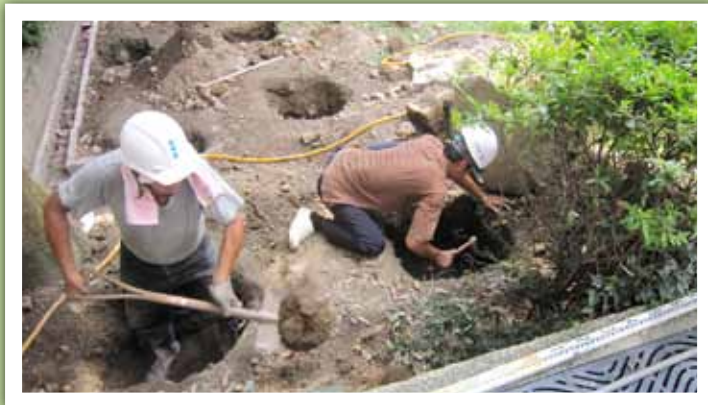
100.6.25 研習大樓中庭木棧步道施工情景
