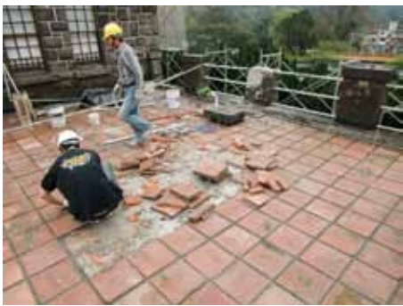
100.3.14 行政大樓露台防水施工情景
