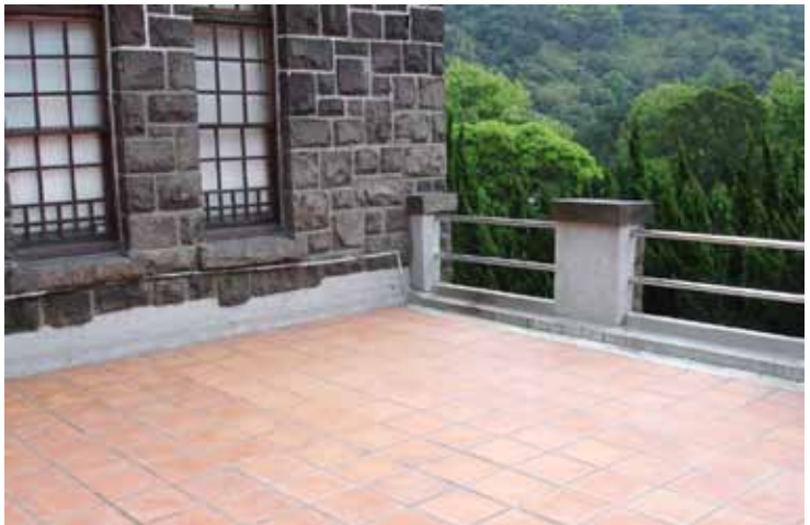
101.4.1 行政大樓露台完工現貌
