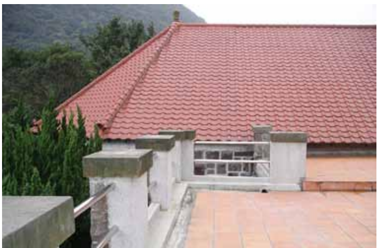
101.3.2 露台欄杆整修後樣貌
