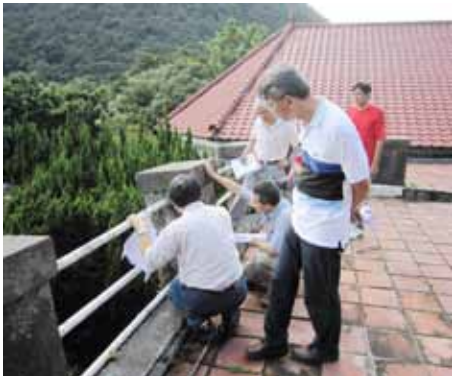
100.3.14 露台欄杆傾斜會勘情景
