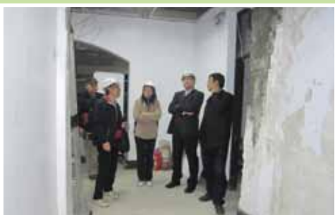
100.3.18 歷史走廊施工期間之巡視
