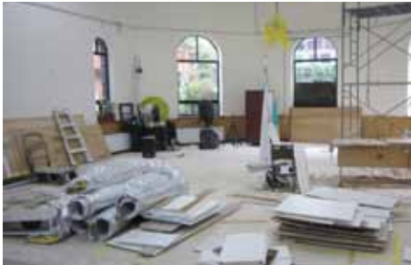
100.5.19 文康室防漏工程施工期間一隅
