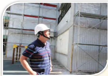
檢視工地現場施工情形
