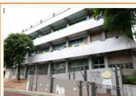
彩繪無障礙坡道
