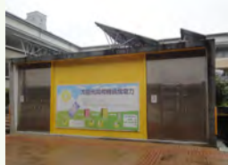
太陽能發電系統
