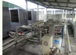
水池熱泵加熱系統
