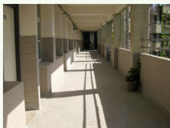
耐震補強後之走廊
