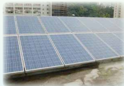
能源教室層頂架設太陽能板
