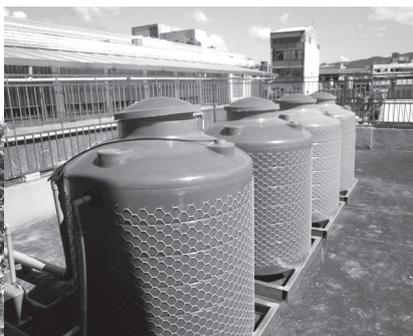
建置雨水再利用系統，以水撲滿儲存雨水。
