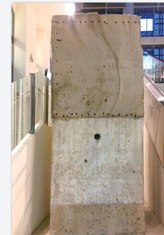
北火發電機基座混凝土柱子
