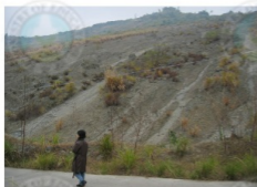
圖9-2 缺乏植被的陡峭坡地 ( 南投縣九分二山 )
