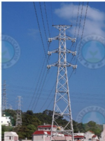
圖11-15 高壓電塔將電壓很高、相當危險的導線架空，以便有效率地將電能從發電廠傳送到住宅。
