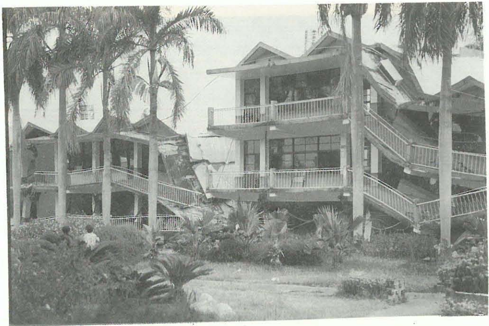
圖 4 霧峰（光復國中，教室因斷層線通過而斷裂）
