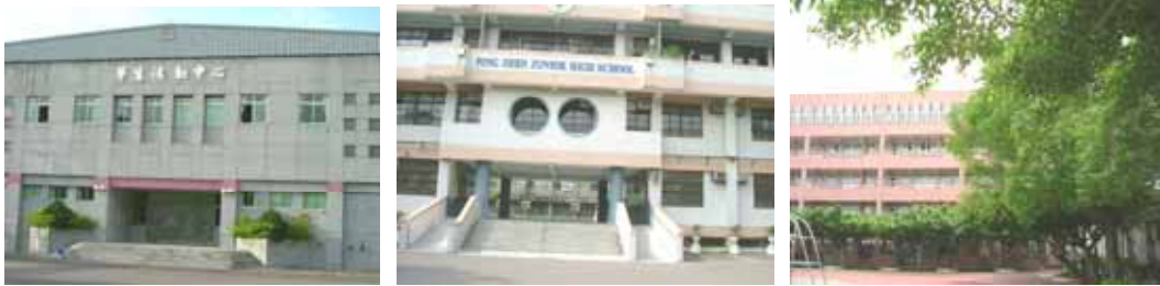
圖30大漢國中新建活動中心 圖31平鎮國中新建教室 圖32新明國中新建教室
