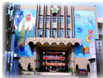
圖 8 台中縣太平市中平國中 以舊有基礎新建藝術化校門
