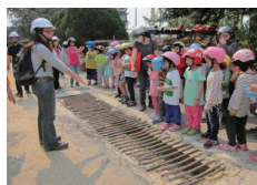
圖 11 認識工地設施
