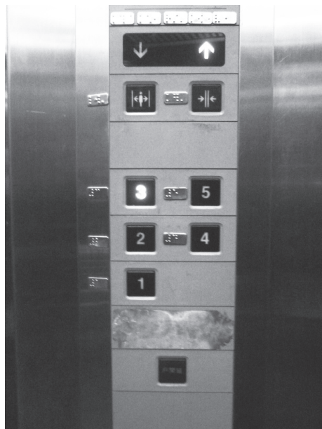
電梯延長開門未做點字標示
