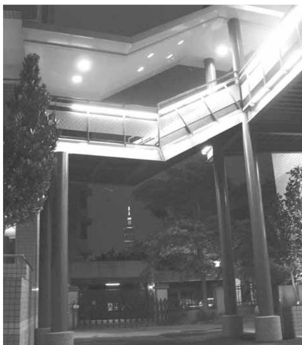
▲ 聯絡走廊工程一夜景
