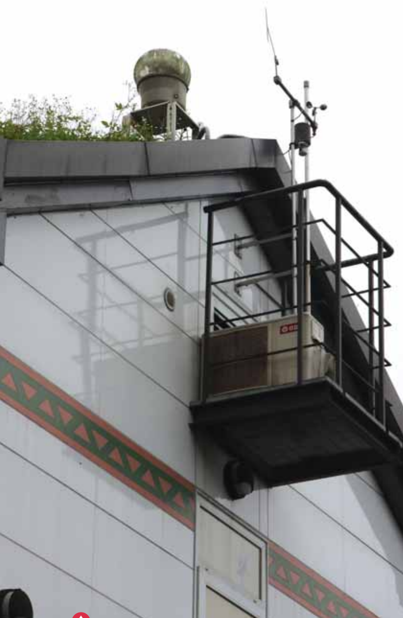
▲ 裝在屋頂上的這個圓球，就是戶外集光器，在有太陽的時候可以收集光線。
