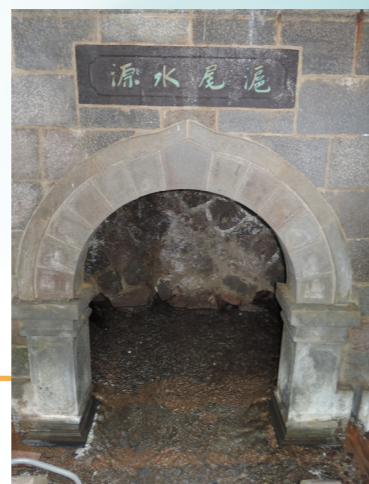
滬尾水道出水口
