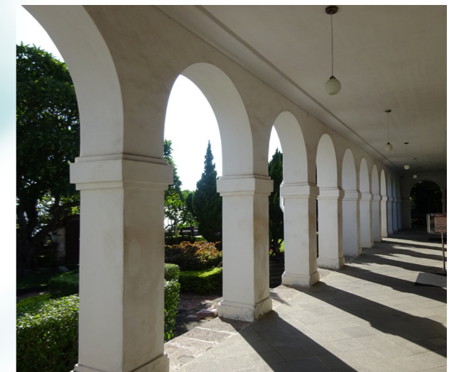
小白宮的涼臺迴廊設置屬於殖民地樣式建築特色
