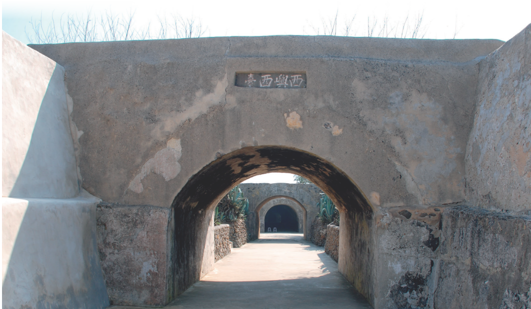
西嶼西臺 (現況)
