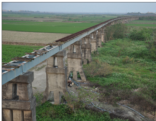
圖 15：北港溪鐵橋（筆者自攝，2016 年 3 月 26 日）
