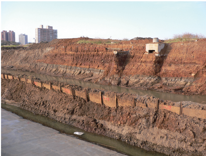
圖5-1 建築工地開挖的泥土／淡水新市鎮
