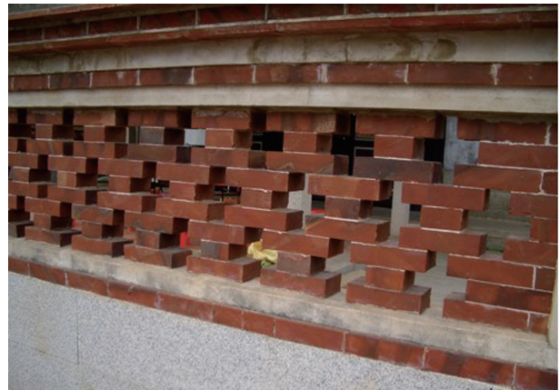
圖3-18 金門國家公園水頭黃俊酉堂別業圍牆的磚砌工法細部。
