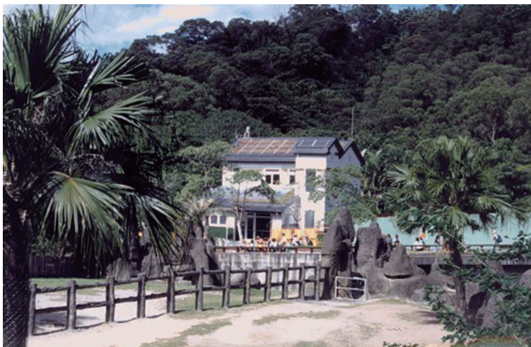
圖1-32 工研院木柵動物園能源屋的屋頂，採用工研院研發之系統單元，包括太陽能光電板、太陽能熱水器、草皮、植栽等特殊單元。
