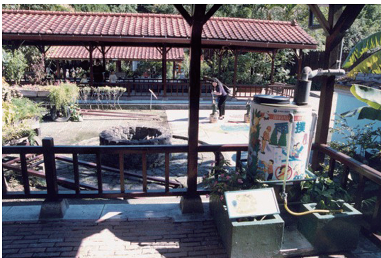
圖1-33 木柵動物園能源屋區設有收集雨水的雨撲滿，將雨水收集再利用。
