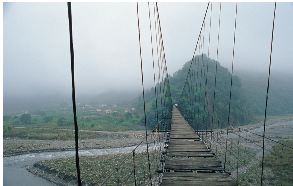
泰安鄉象鼻部落大安吊橋
