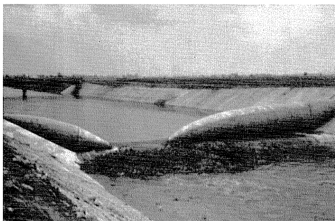
洩氣時之橡膠起伏堰
