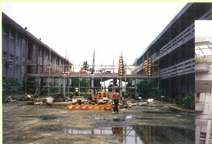
▲民國83年修建第二、三棟教室的中走廊
