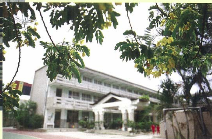
▲第二棟教室現景
