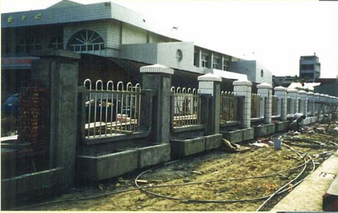
▲民國82年，圍牆整修工程
