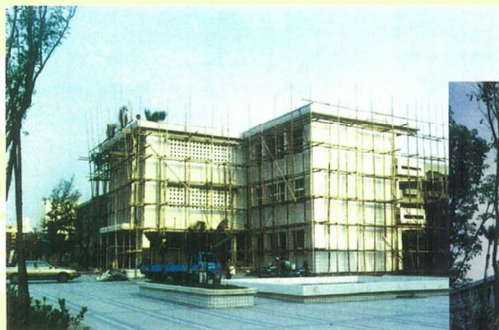
▲民國84年校舍修建工程
