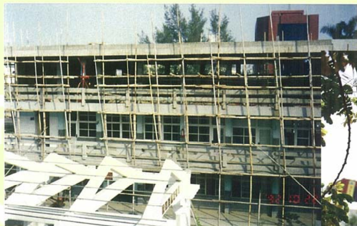
▲民國81年第二棟教室三樓興建情形
