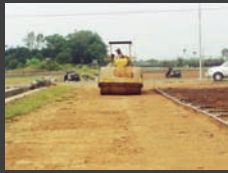
使用大型機具壓實步道，整平路面
