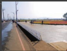
增設多處白色隔欄
