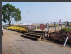
興建多處便橋(含扶手欄杆)，以便遊客確知路程
