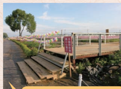
興建多處便橋（含扶手欄杆），以便遊客縮短路程
