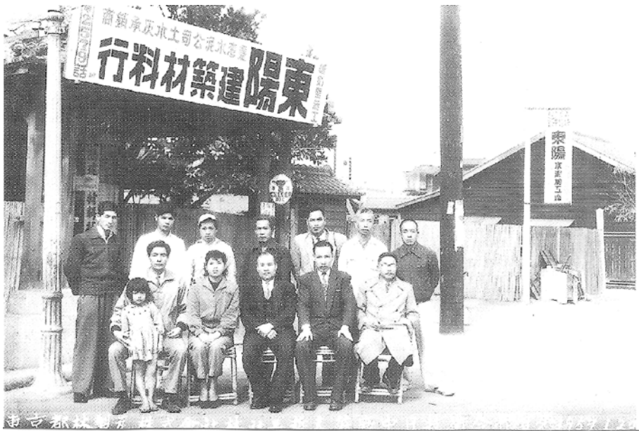
照片10:東陽水泥在仁愛路的商店與工地
