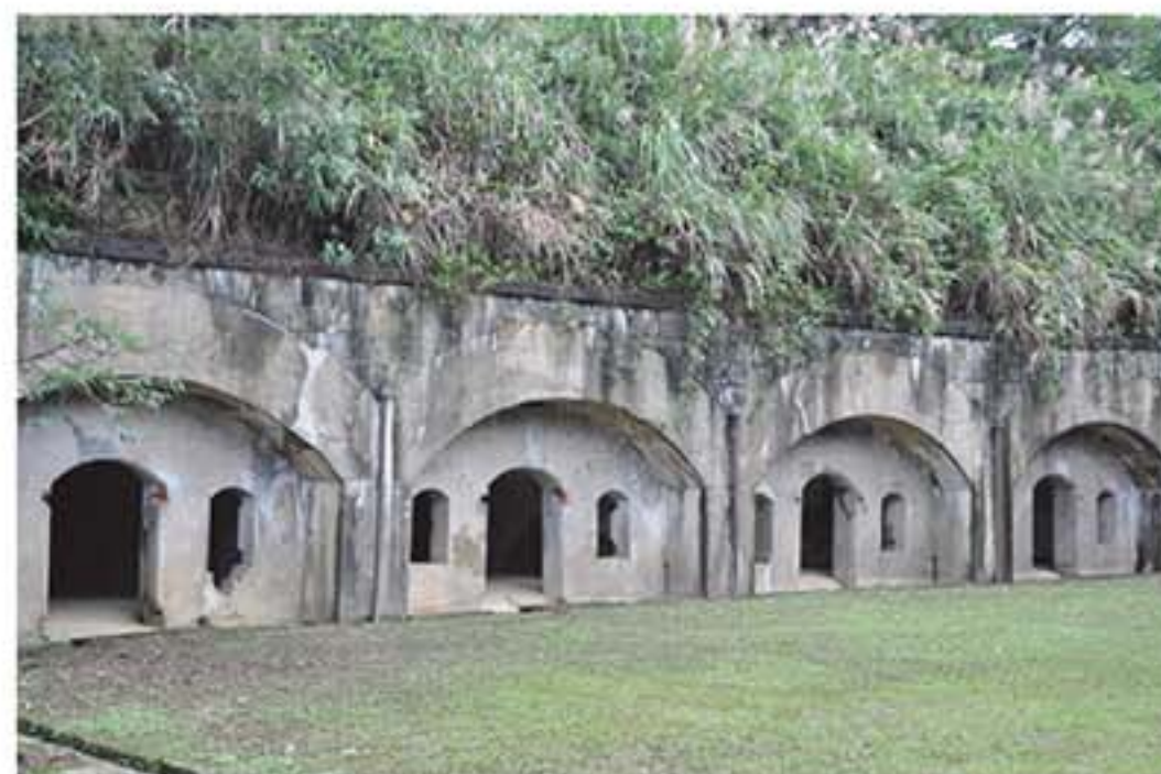
四腳亭砲臺—掩蔽部
