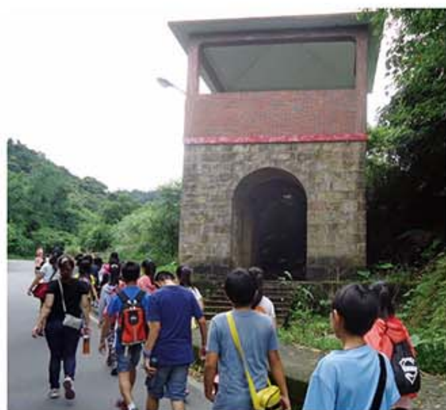
後來興建的「四腳亭」建築地標， 用來紀念當年四腳亭古道
