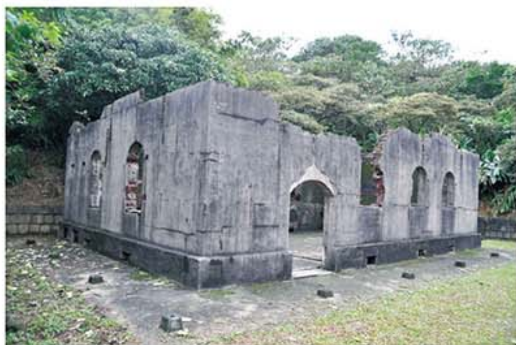
四腳亭砲臺－監守衛舍
