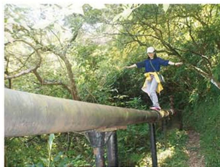
隱身山中，高架的水管路
