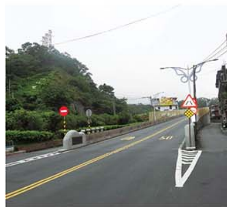
第一座越過鐵路的柑坪陸橋
