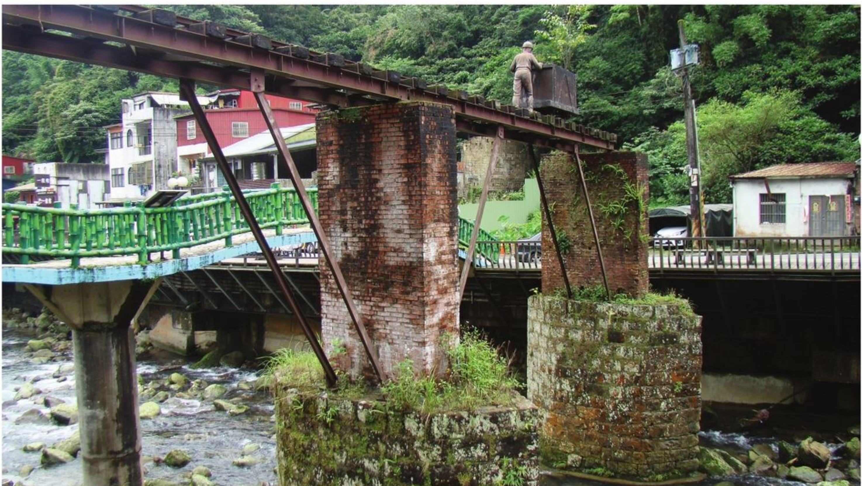
烏塗溪橋橋墩 (李水德攝)
