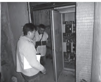
送電機房維修
