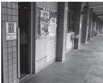
柱角安裝防撞條確保學生安全
