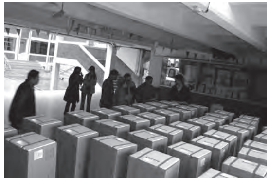
班級教室冷氣室內機安裝
