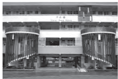
中正樓外牆拉皮正面
