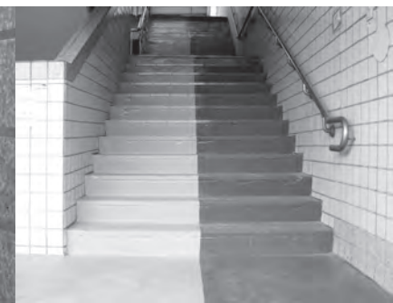
樓梯改為金剛砂表面防滑處理
