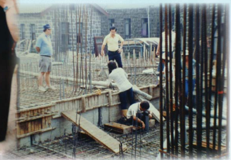
▲ 74.12 綜合大樓施工(卓英豪副主任巡視工地)
