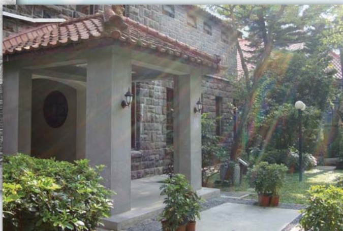
▲100.8.18 行政大樓現貌
