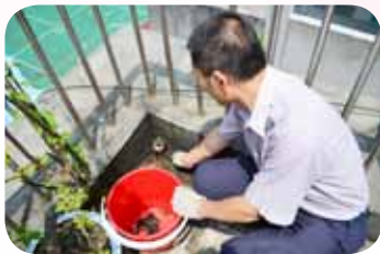
積極防颱 - 屋頂排水孔疏通
