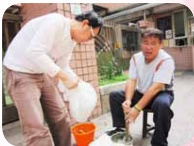
協同工友填補地埤坑洞
