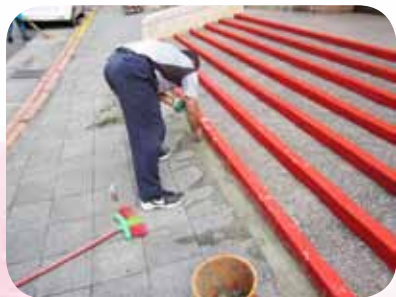
修補地坪坑洞
