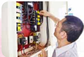
水電醫生 - 修理電器
