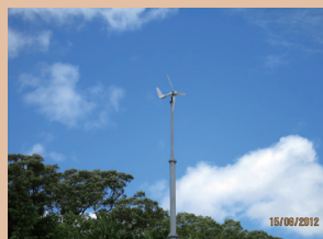
建置風力發電機提供 夜間及教室照明
