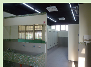
和平樓廁所整修
