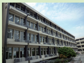
建築物外牆整修
