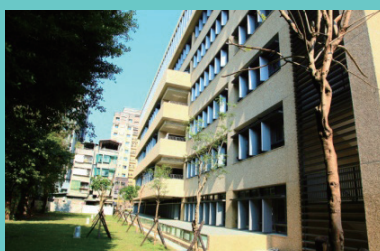
垂直式遮陽板降溫省電，阻擋早晨、午後輻射角度較低陽光
