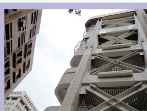
補強工程增添耐震能力
