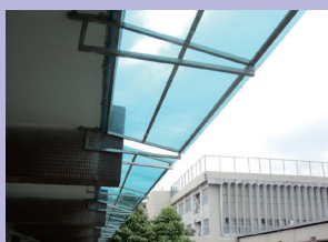
完成校舍三樓雨遮建置，走廊不再濕滑，親師生活動更安全。
