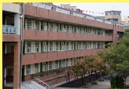
自強樓外牆補強的新貌提供校園安全無慮環境
