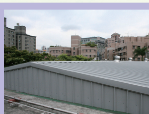
架斜屋頂解決漏水夢魘
