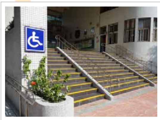
● 大門口樓梯無障礙環境改善工程
