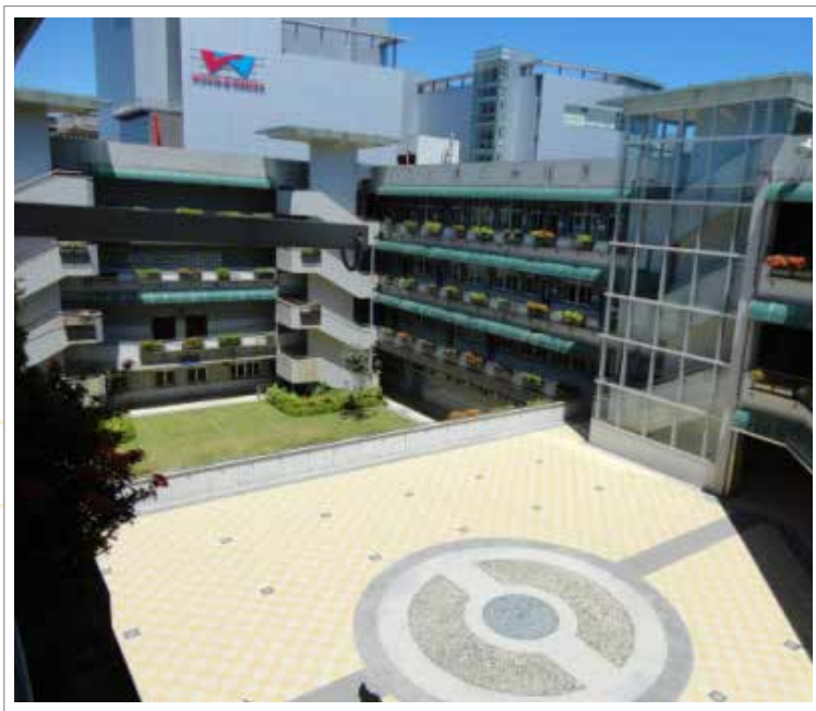
● 中庭地坪改善工程
