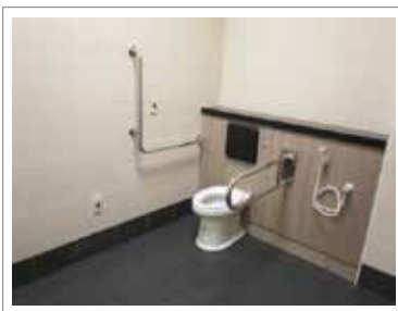
● 音樂廳外無障礙廁所改善
