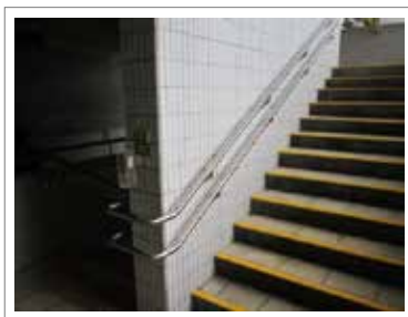
● 樓梯加掛無障礙雙層扶手
