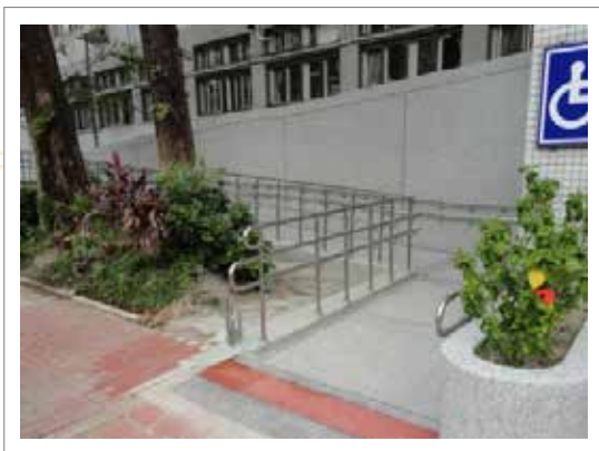
● 大門口斜坡道無障礙環境改善工程
