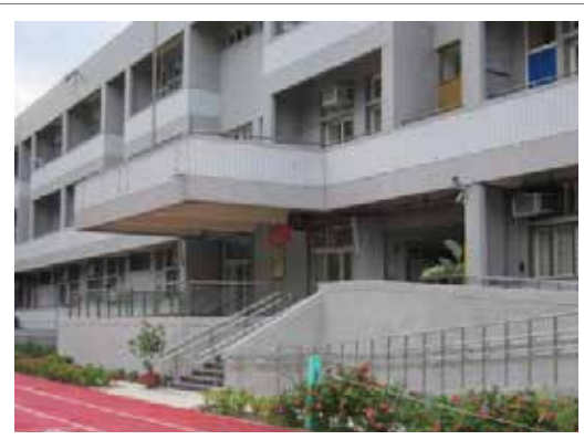
• 司令台斜坡道改善工程
