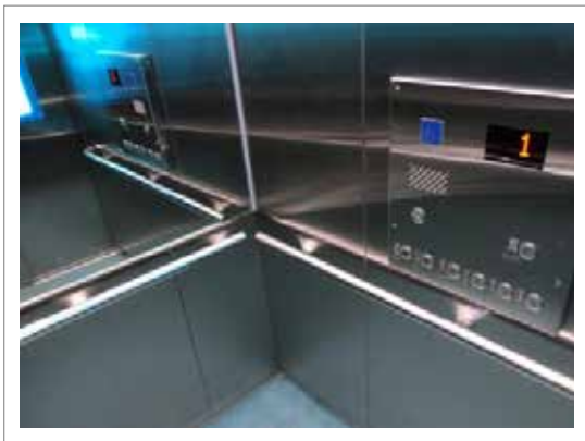
● 電梯無障礙設施改善
