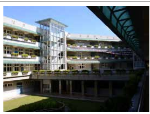
• 樓梯外牆玻璃包覆（4 號樓梯）及走廊欄杆加高工程
