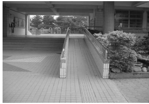
圖 4-12 某國小坡道上設置導盲磚
