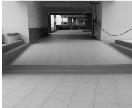
圖 4-8 南科國中廊道針對高低差的部分以緩坡來修飾，並設置停等區
