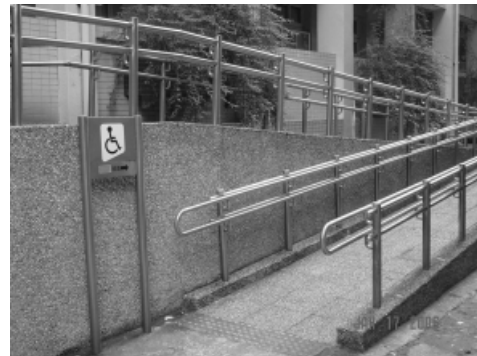
圖 4-10 中山女高無障礙坡道上設置兩道扶手，且扶手末端向內迴轉，保護使用者安全
