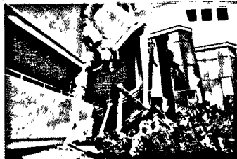
(03)行政大樓因地震而傾塌
